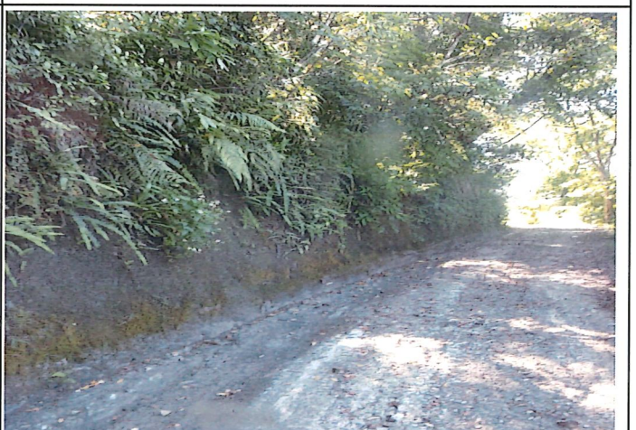
(6)5k+900處 座標X:276865 Y:2573649 路面淤積汛期前排水施工機具及人員於現場施工後
