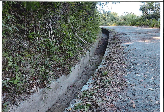
(2)3k+450處 座標X:277990 Y:2574452排水設施清淤完成
