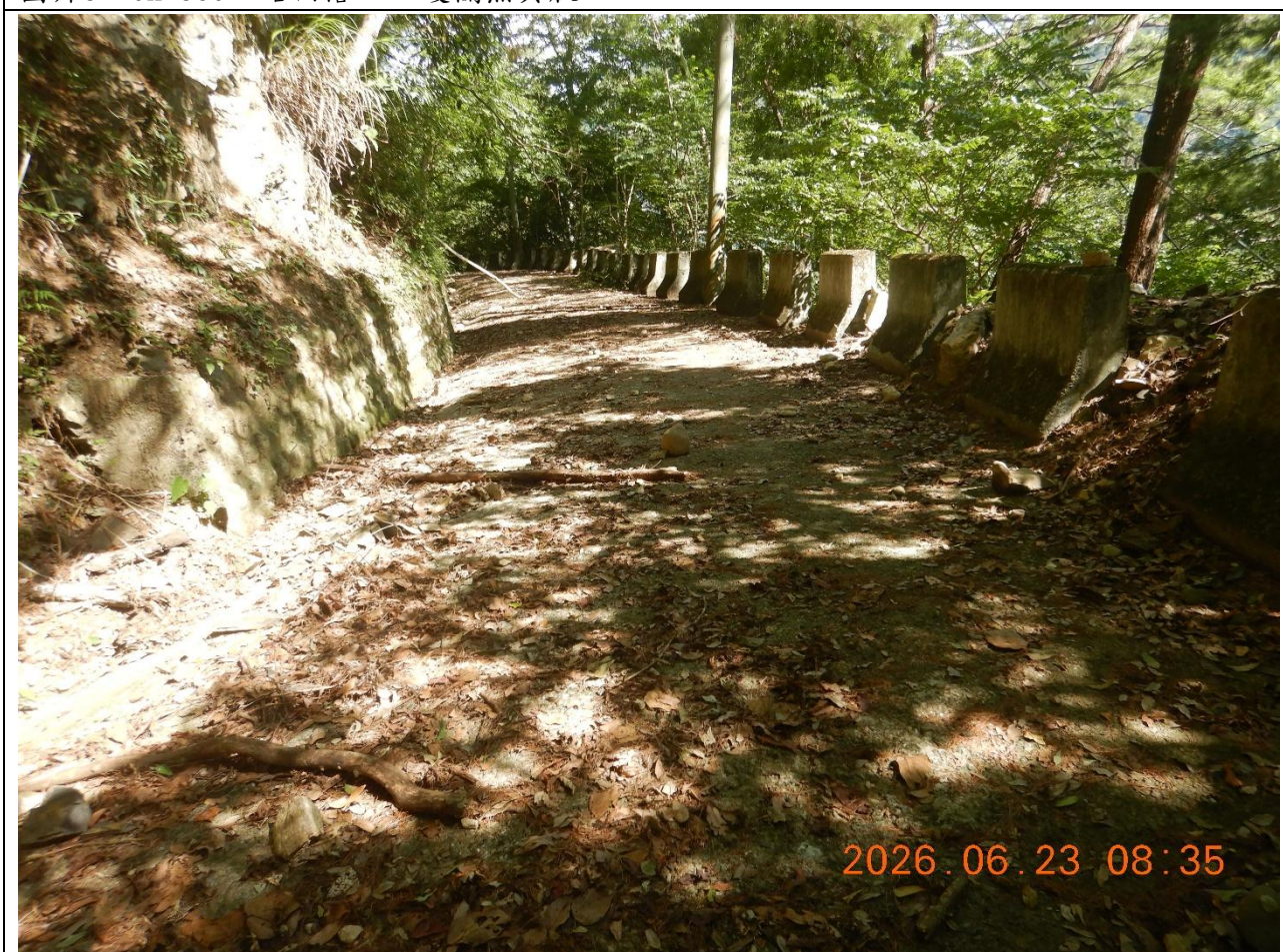
圖片6：0K+600，路面及邊溝枯枝落葉堆積，護欄無異狀。
