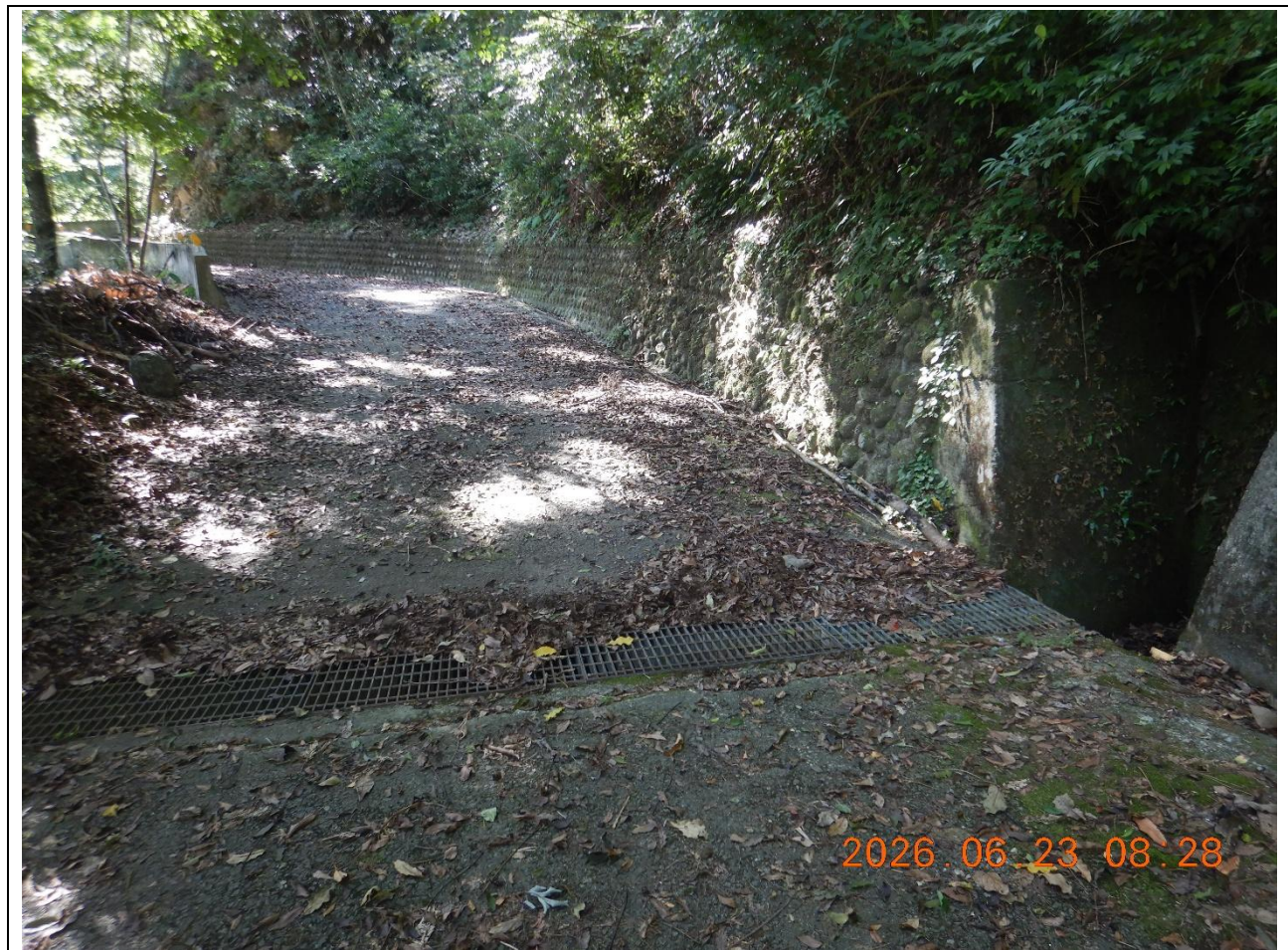
圖片3：0K+300，截水溝，落葉堆積。
