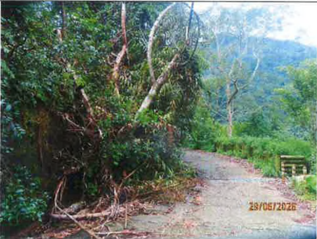
烏石坑林道巡視，X：244051，Y：2686358，坡面倒木。
