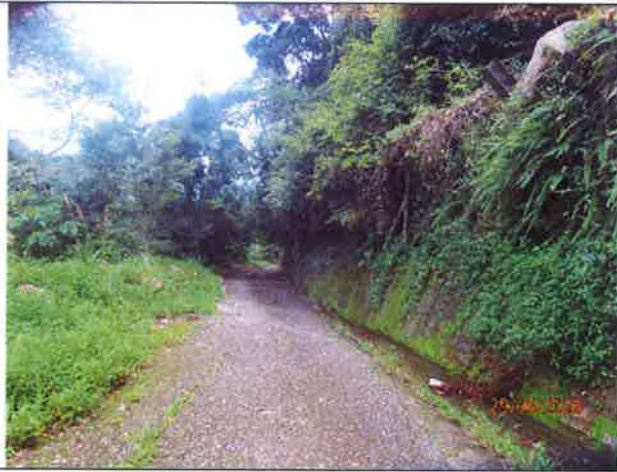
烏石坑林道巡視，X：244126，Y：2686224，路面破碎截水溝蓋露出情形，防落石網遭落石壓迫損壞。
