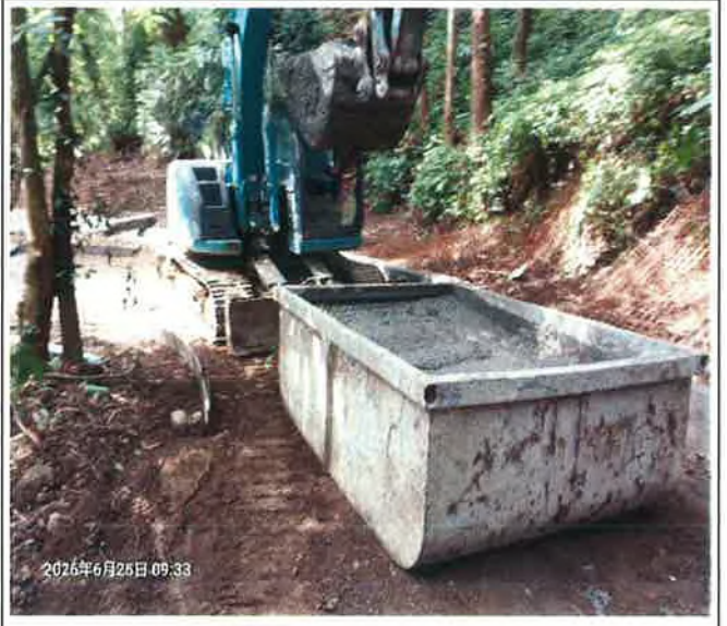
林道路面鋪設水泥
