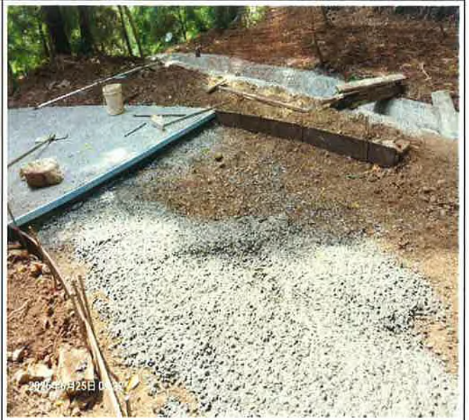
林道路面鋪設水泥
