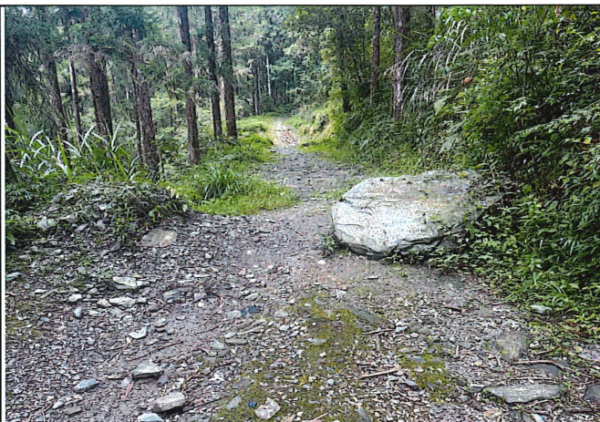
(8)林道17k+850處路面落石道路縮減，機車可通行 座標：X:278130；Y:2602311。
