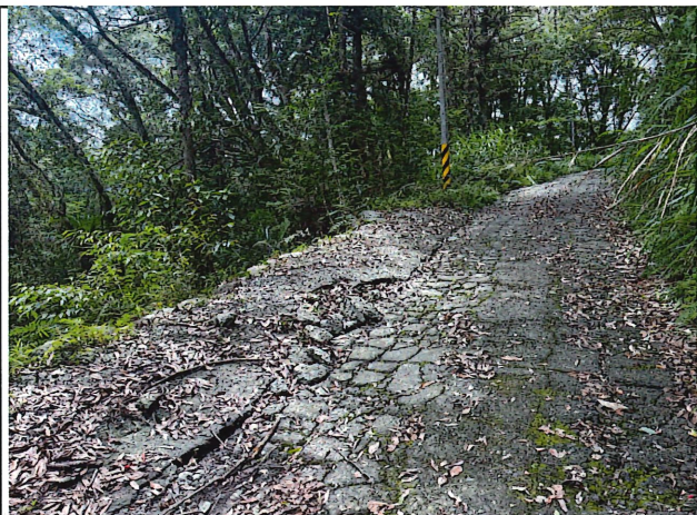
(7)林道10k+900 處 水泥路面破碎 座標：X:278987；Y:2599040。
