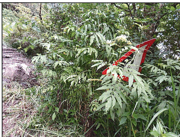
照片2：中平林道7k+390處座標X：279718、Y：2590183。 注意落石 標誌 傾倒變形。
