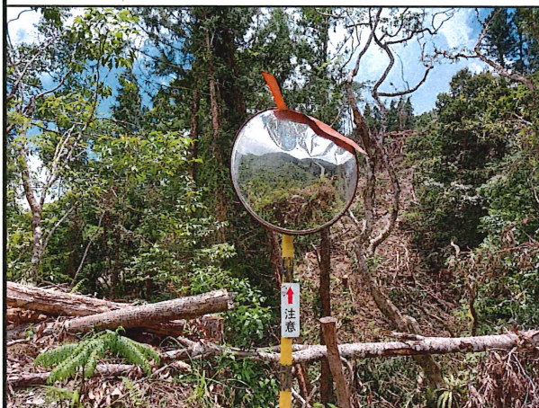
照片3：中平林道10k+900處座標X：278249、Y：2590600。 反光鏡遭撞擊變形。
