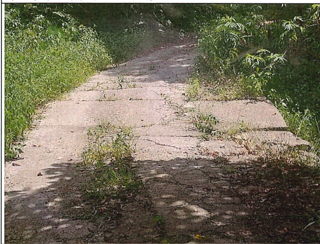
(5) 8K+080處 座標X:275173 Y:2573079 林道路面呈現劣化混凝土碎裂／破損，建議進行刨除與平整化修補改善。
