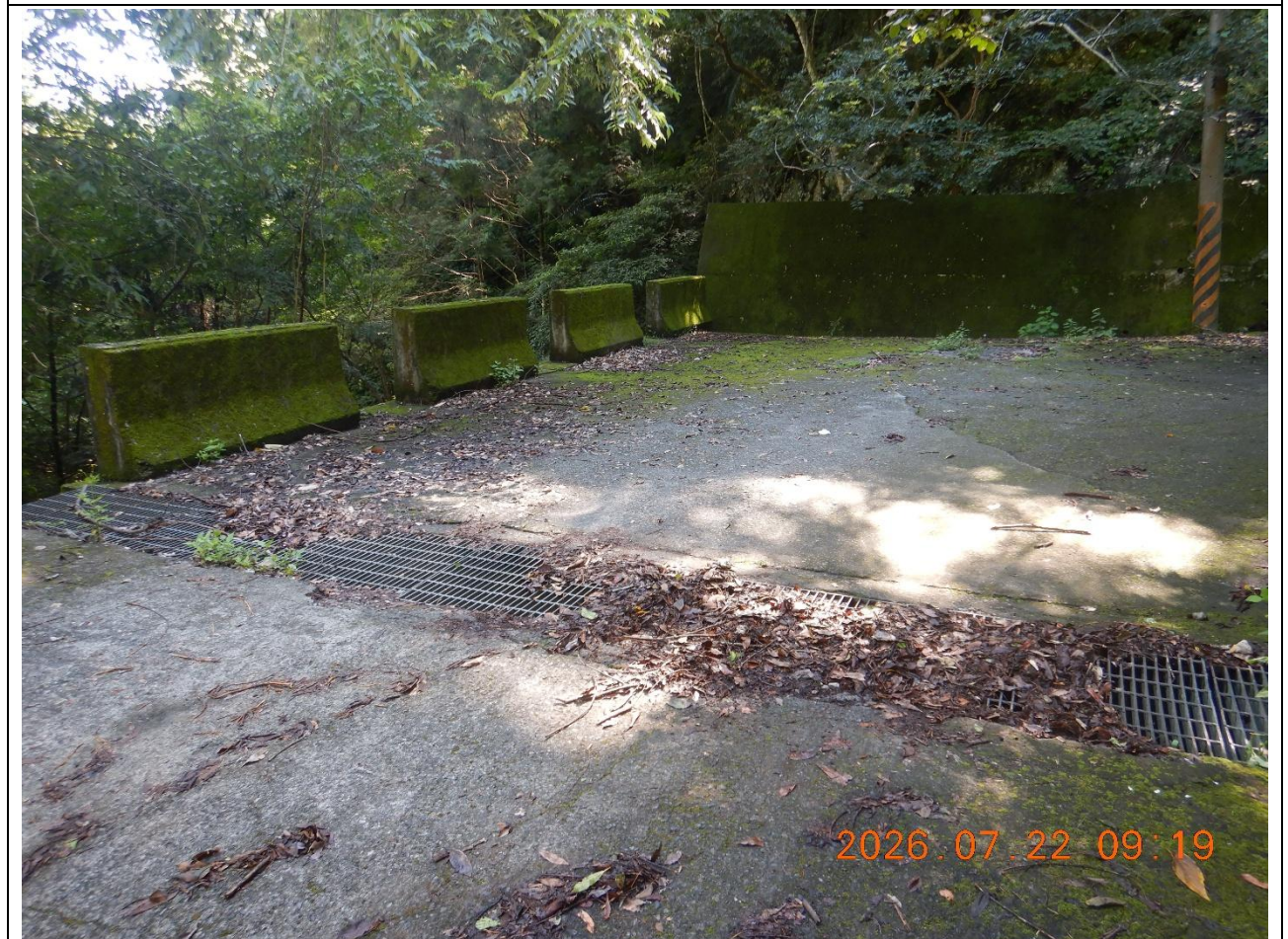
圖片2：0K+200，截水溝，落葉堆積。
