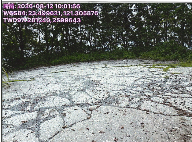
(7)林道6k+200處 路面碎石破碎 座標：X:281240；Y:2599643。
