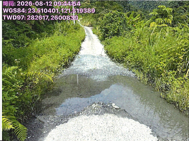
(1)林道0k+800處 路面積水 排水不良 座標: X:282617; Y:2600839。
