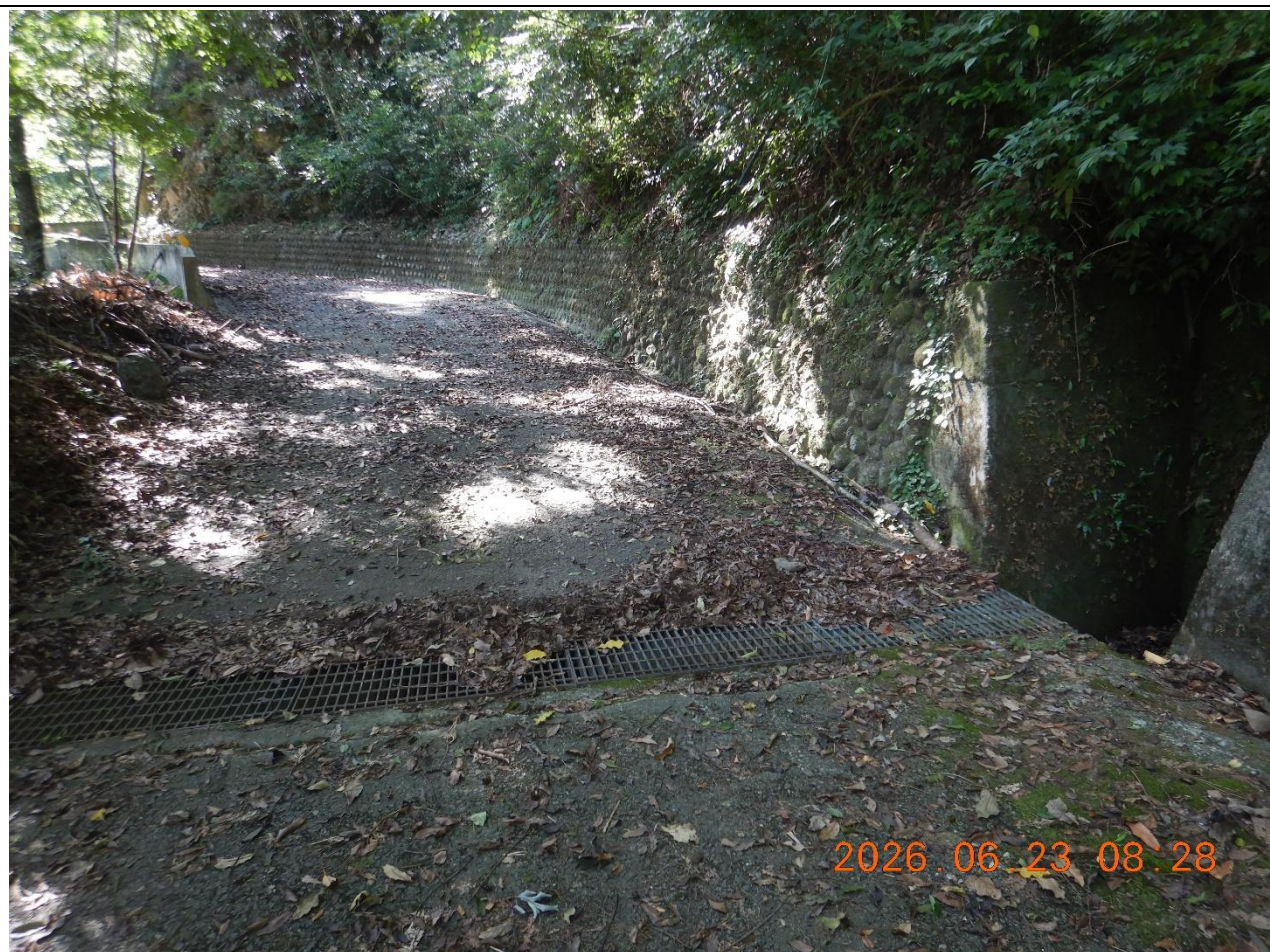
圖片3：0K+300，截水溝，落葉堆積。
