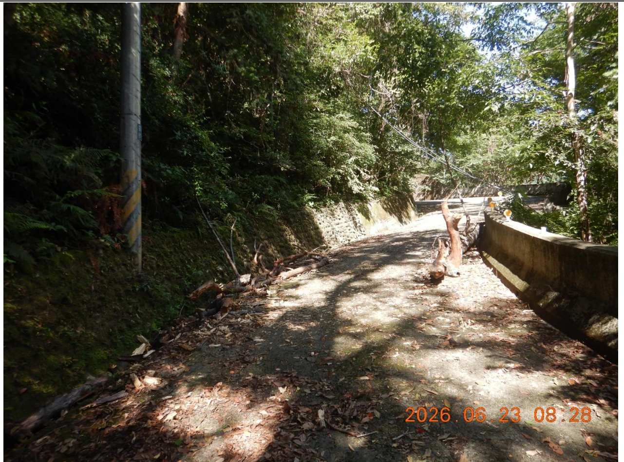
圖片2：0K+270，路面有倒木，邊溝堆積，護欄，無異狀。
