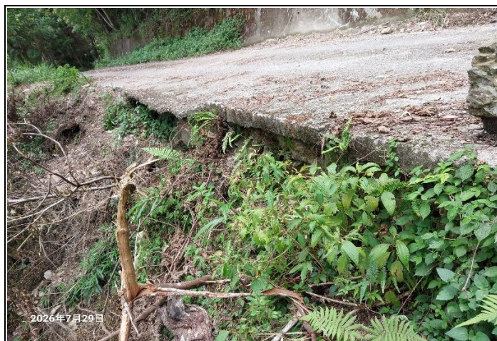
裡冷林道6K+300處，林道路面下方有掏空的情形，目前沒有太大的變動，持續觀察中。
