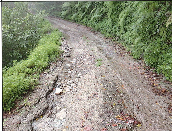
(3)林道8K+600處；座標：X:279188；Y:2590973。路面沖刷凹陷。
