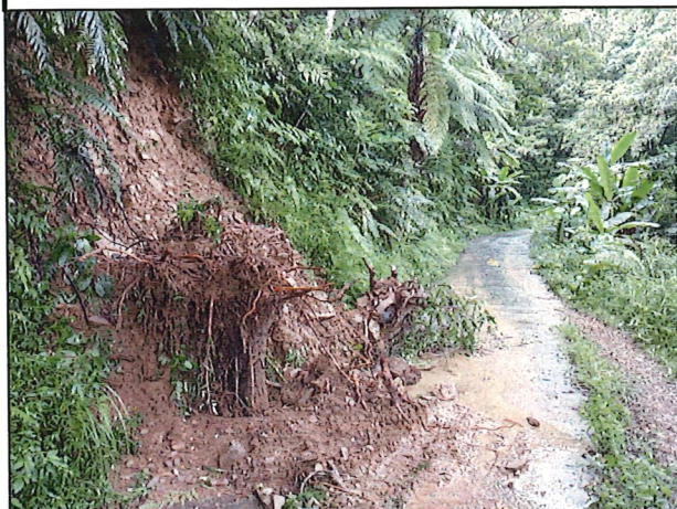
(1)林道5K+500處；座標：X:280520；Y:2589899。邊坡崩塌3*2米。
