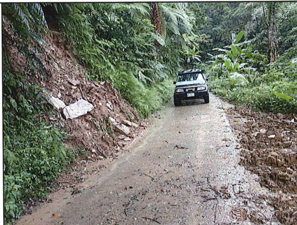
(1)林道5K+500處；座標：X:280520；Y:2589899。邊坡崩塌處開口廠商已處理
