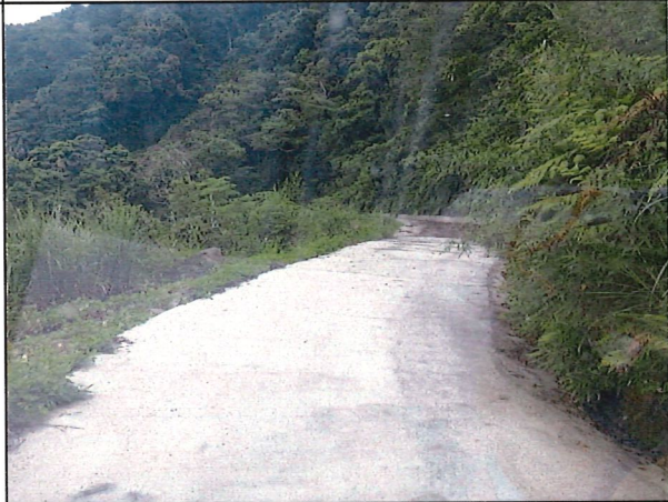
(4)9K+400處 座標X:274523Y:2572183 為建 議單側路肩增設警示桿，增加山區起霧時用路人行車安全。
