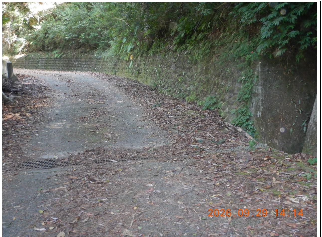
圖片3：0K+300，截水溝，落葉堆積。
