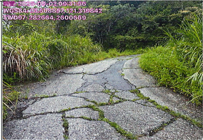
(2)林道1k+200處 路面破碎 座標：X:282664；Y:2600669。
