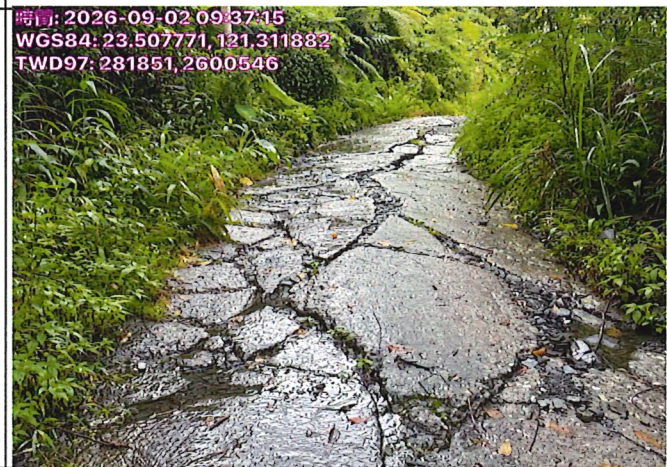
(2)林道1k+200處 路面破碎 座標：X:282664；Y:2600669。
