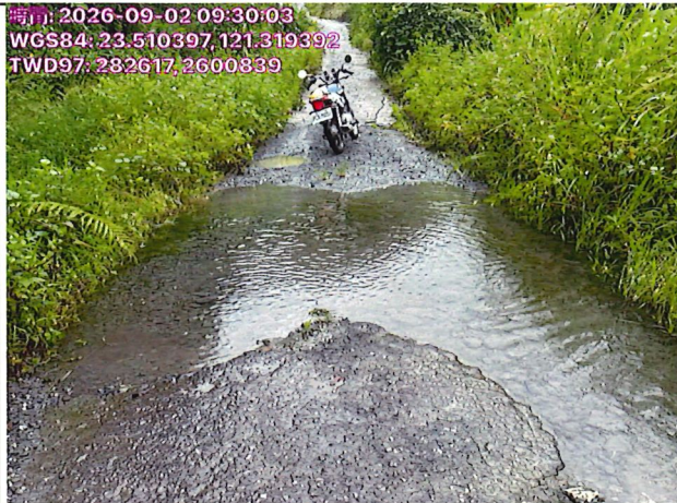
(1)林道0k+800排水不良、路面積水深度至腳踝 座標：X:282617；Y:2600839。
