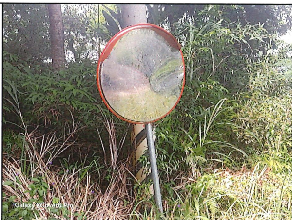
(8)2K+600處 座標X:278177 Y:2574725 彎道反光曲面鏡不明原因凹陷，疑似遭受碰撞。
