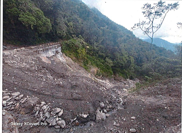
(6)10K+200座標X:273862 Y:2572077 為 開口契約承攬廠商進行林道改善工程，該工區開口契約廠商(欣安富營造)工程尚持續進行中，有重修設置臨時便道方便人車通行林道以上。
