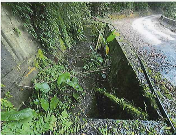
2K+100 動物廊道 現狀照片 (拍攝日期:2026/5/28)
