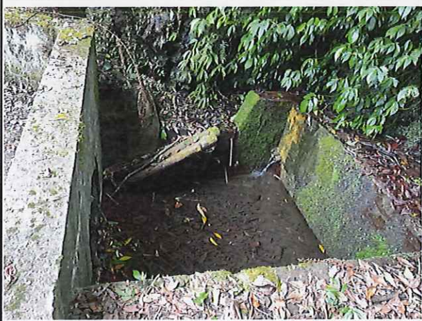
1K+800 動物廊道 現狀照片 (拍攝日期 2026/5/28)
