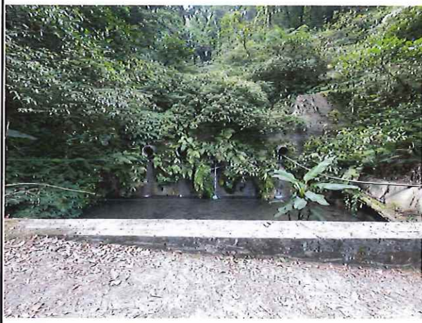
2K+150 動物廊道 現狀照片 (拍攝日期:2026/5/28)
