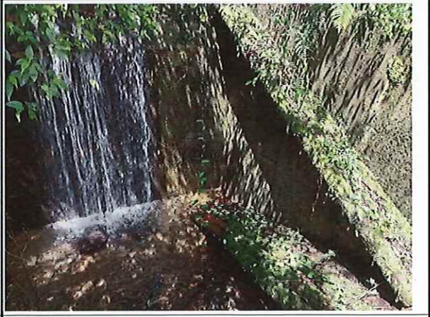
6. 8K 動物廊道現況照片 1150526
