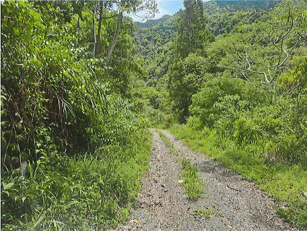
大湖溪林道 115 年 5 月現場照片
