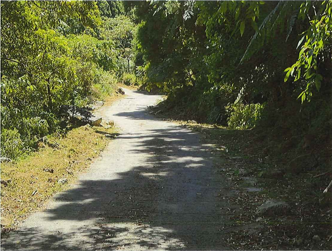
蓬萊林道 115 年 5 月份現場照片
