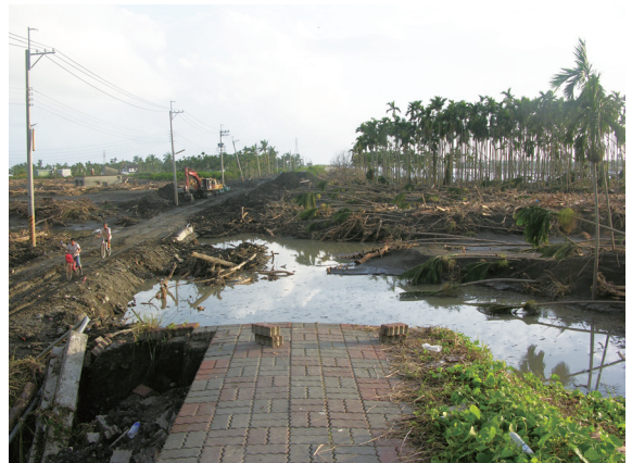
▲照片2 漂流木及洪流衝破林邊溪右岸堤防。
