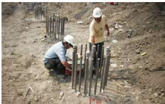
(4)超音波檢測樁體混凝土澆置品質
