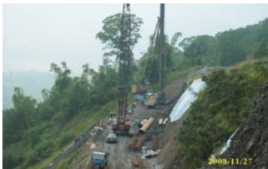
(3)基樁鑽掘與鋼筋籠製作
