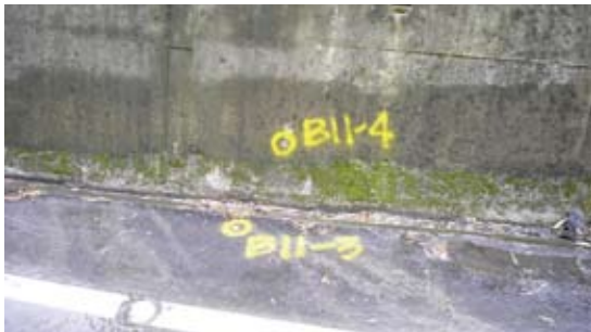
(2)地表沉陷點亦可設置於結構物
