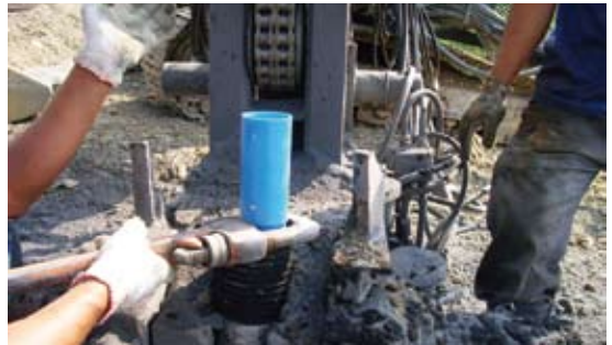
(1)利用鑽機鑽孔或鑽探後空孔安裝管材
