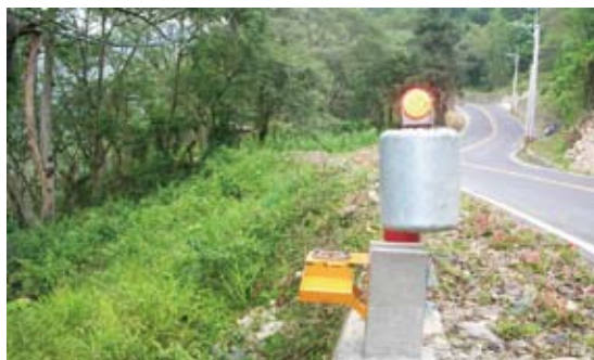
(1)安裝時應要求水平安置底座與固定
