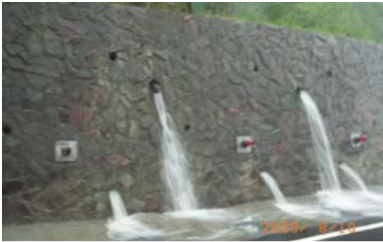
(1)水平排水管排除地下水情形
