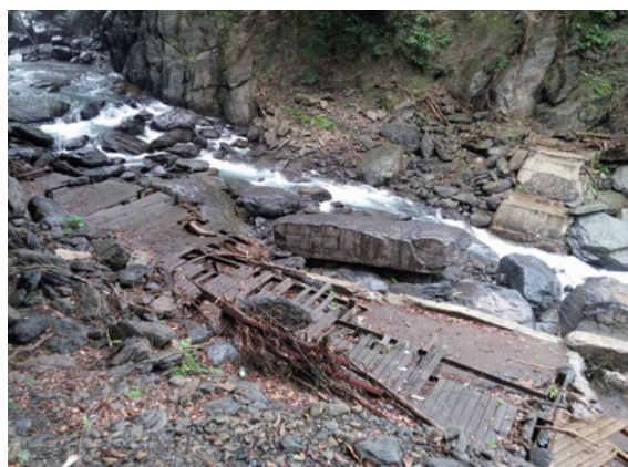
▲內洞溪下游兩岸構造物損毀
