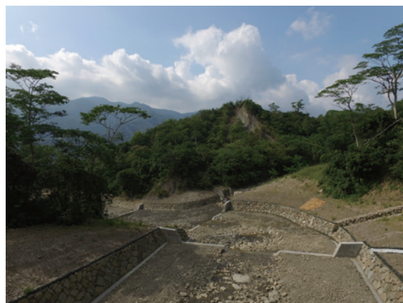
▲以溪中塊石，砌築護岸。
