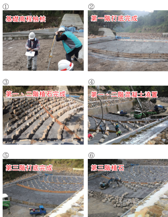
▲圖6、粗石斜曲面魚道施工過程示意圖
