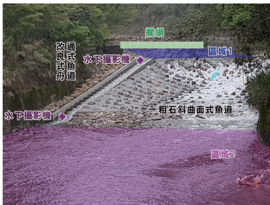
▲圖8、橫流溪魚道溯游魚類調查配置示意圖（照片經加工套色，非原水體顏色。）
