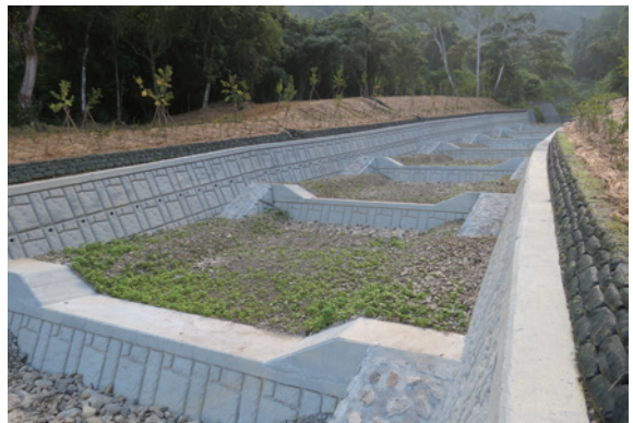
▲圖8、設計方便蛙類及爬蟲類攀爬的高差通行方塊（攝影／張凱博）
