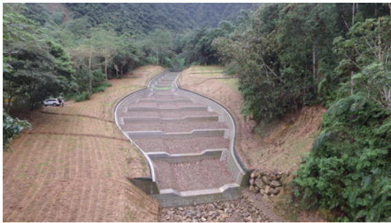
▲圖6、「魚池鄉白石牙野溪整治工程」於下游擴大斷面營造土砂庫容區，配合平時維護管理，可有效保全下游九族文化村及大林村民安全。（攝影／林永欣）
