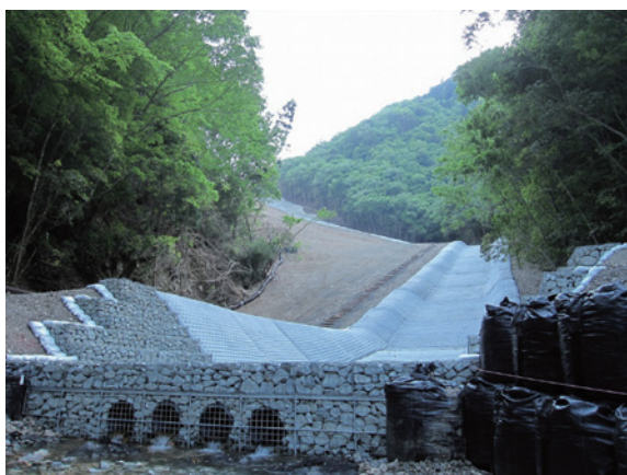
▲圖7、【長殿地區】緊急對策工（臨時排水路工程）
