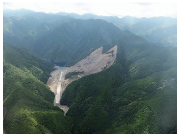
▲圖8、【栗平地區】緊急對策工程；臨時排水路（剛完工）
