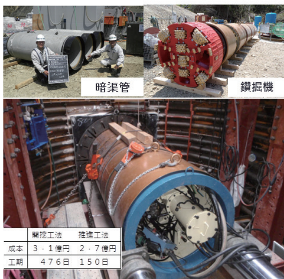
▲圖 11、利用推進工法佈設暗渠排水管
