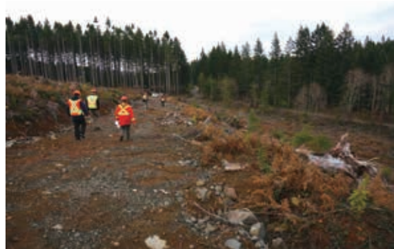
▲ 採伐後便道碎石鋪面移除至下一作業區，同時保留排水系統。
