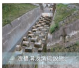
乾砌石駁坎及固床工
