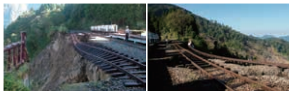
▲圖1、莫拉克後二萬坪月台邊坡滑落情形（拍攝日期：98年9月）
