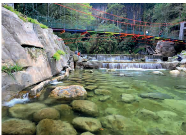
阿里山 107 林班保育治理工程仿岩護岸設置魚道供魚類上溯及躲避鳥類補食。 （攝影／林業保育署南投分署 黃俊豪）
