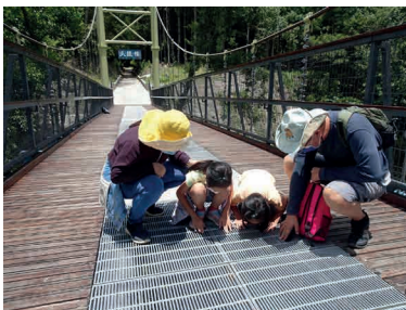
武陵吊橋修繕工程以不落墩的方式降低對溪流生態的干擾，橋面板中央的鏤空設計增加排水、透空性，更方便俯瞰七家灣溪。 （攝影／林業保育署臺中分署 劉保安）
