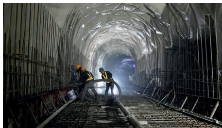
隧道鋪設防水膜及澆置隧道混凝土，強化防水及安全。 (阿里山林業鐵路及文化資產管理處提供)
