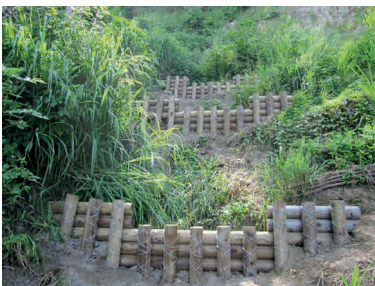
大安溪山腳圳旁崩場地處理工程利用國產柳杉疏伐的圓木、小徑木、竹片等自然素材設計木排欄，減低工程對環境的擾動。 （林業保育署新竹分署提供）
