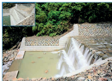
大埔 137 林班防砂工程將砌石護岸緩坡化，打造可供動物使用的通道。 （林業保育署嘉義分署提供）
