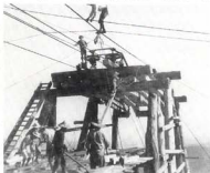
▲民國58年颱風災害後，蘭陽處大元山工作站員工，以直營方式重建大元索道（林木溪提
