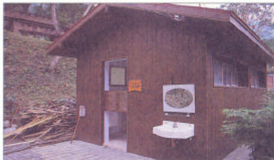
木造雨淋板「橫」「豎」不重要，只要是廁所就好。
