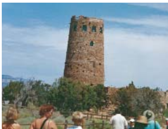
▲從遠處看大峽谷山頂的石屋展望台高20餘公尺，建造於面臨科羅拉多溪邊懸崖處，相當堅固結實，據說是早年由印地安人所建。
