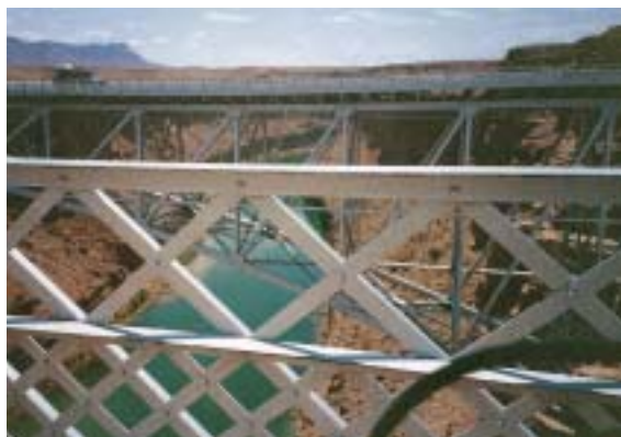
▲跨越科羅拉多溪谷之大鐵橋。
