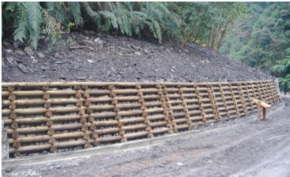
圖38 木製校倉式擋土牆完成圖
