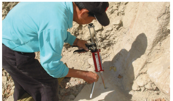
圖17 以二液型速乾塑鋼土(VMK235)固定螺栓
