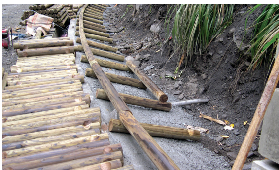
圖35 近坡面底層圓木棒之組立 (基礎上方兩支2m長圓木棒間隔80cm互成平行，以螺絲固定於上方，成井字型)
