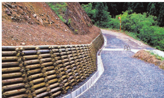
圖6 擋土牆護坡工程實例(擁壁法)
