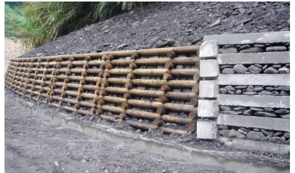
圖39 木製校倉式擋土牆完成圖
