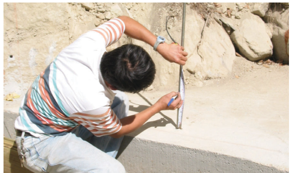
圖16 螺栓高度丈量
