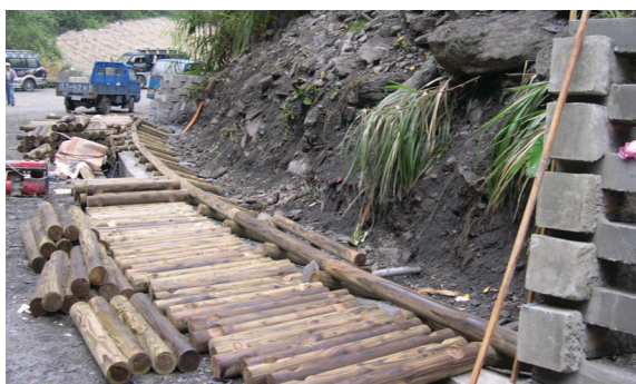
圖32 施工基地及ACQ防腐處理圓木棒
