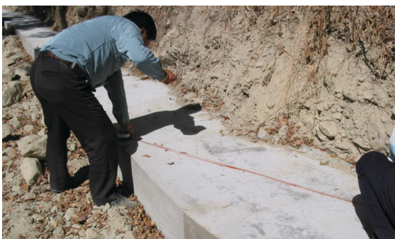
圖14 施工線打樣
