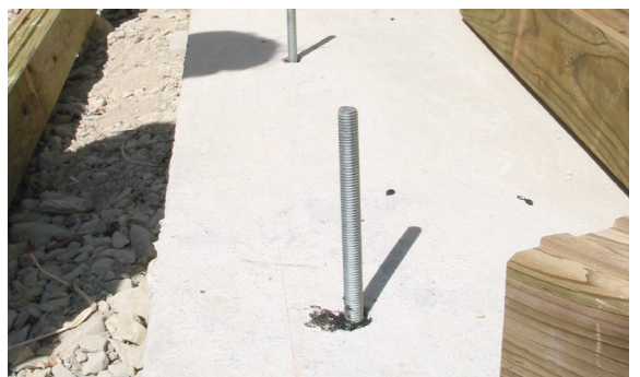
圖18 螺栓固定於混凝土基礎
