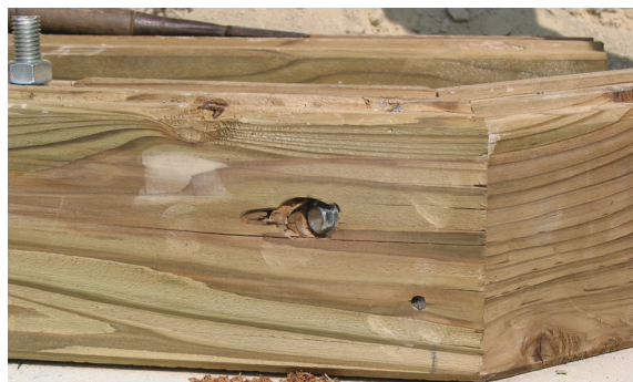
圖22 log釘固定完成
