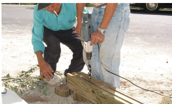
圖20 最底層D-Log原木鑽孔
