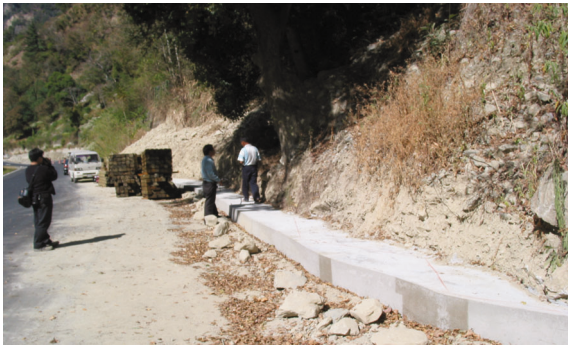
圖11 混凝土基礎完成
