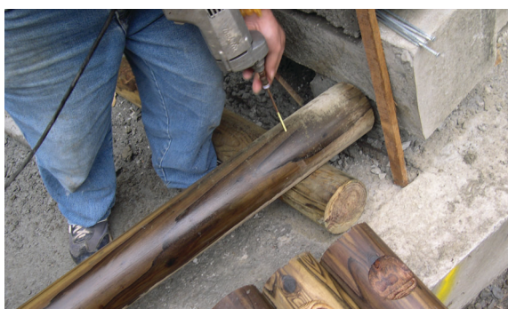
圖33 最底層圓木棒以木攻螺絲固定
