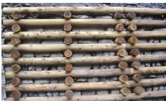
圖37 完成木製校倉式擋土牆之組立
