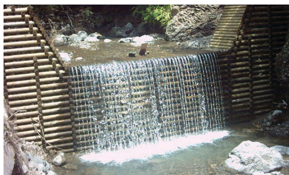
圖7 木製攔砂壩工程實例
