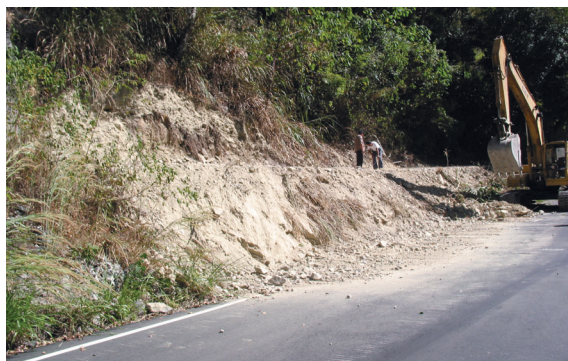
圖10 施工基地整地
