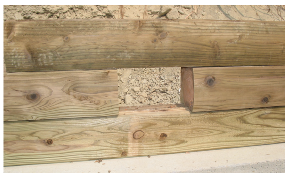
圖23 第二層以上D-Log原木間隔25~30cm孔隙以利排水，並逐層組立
