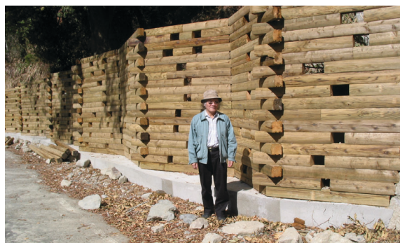
圖24 木造檔土牆施工完成
