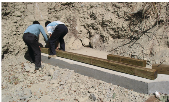
圖19 圓木放置於基礎上，確認鋸切尺寸
