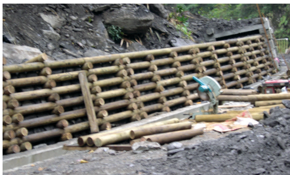
圖36 依前述作業步驟，延長擋土牆長、寬、高，直至預定尺寸
