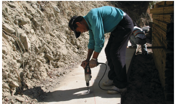
圖15 螺栓孔鑽孔
