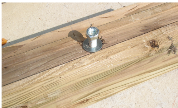
圖21 鎖上螺帽固定底層D-Log原木
