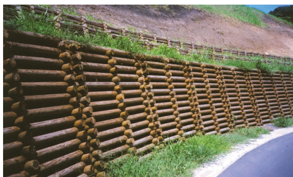
圖5 擋土牆護坡工程實例(擁壁法)
