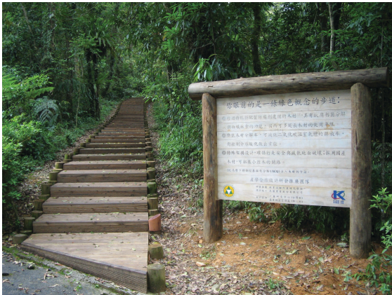
▲完工後的階梯式木棧步道
