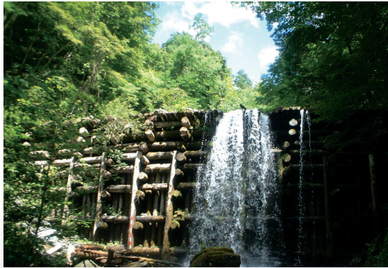
圖11 木堰堤：1983~1991年補修，補強施工堤高：8.0 m，天端幅(上長)：24.0 m，最大原木直徑：40 cm，最小原木直徑：25 cm
