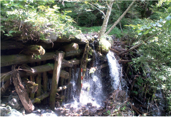
圖10 木堰堤：1959~1960年施工堤高，5.5 m，天端幅(上長)：20.0 m，最大原木直徑：40 cm，最小原木直徑：25 cm
