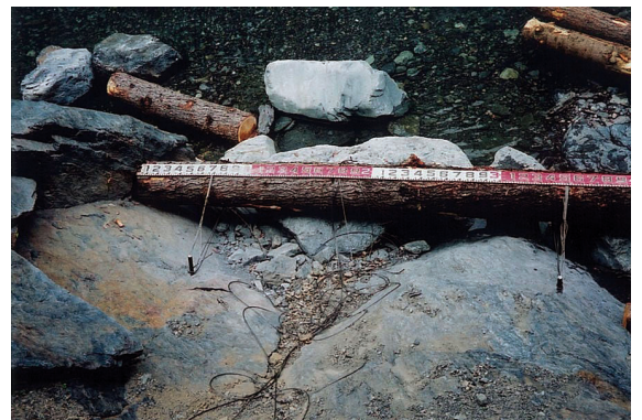
圖2 防止大水流失，以錨固定
