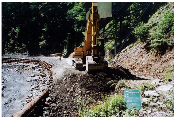
圖4 施工時填土狀況
