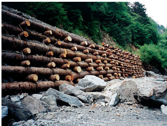
圖6 完工後之近景
