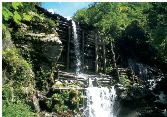
圖7 木堰堤：1983~1991年補修，加強施工 堤高：10.0 m 天端幅(上長)：12.5 m，最大原木直徑：45 cm，最 小原木直徑：20 cm
