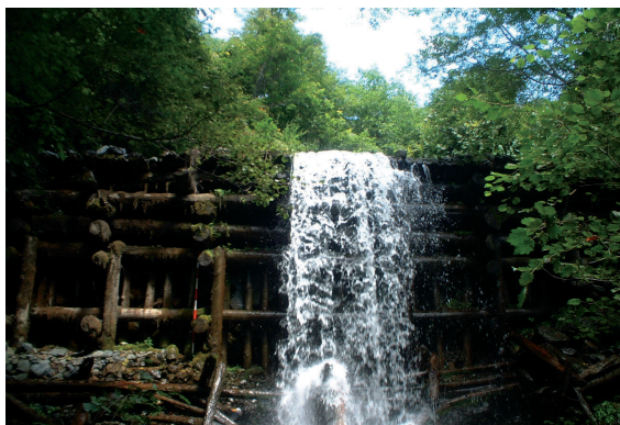
圖9 木堰堤：1983~1991年補修，補強施工堤高：5.0 m ，天端幅(上長)：27.0 m，最大原木直徑：40 cm， 最小原木直徑：25 cm
