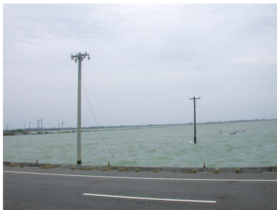
照片5 西海岸因地層下陷導致海水倒灌情形（攝影 / 鄧書麟）。
