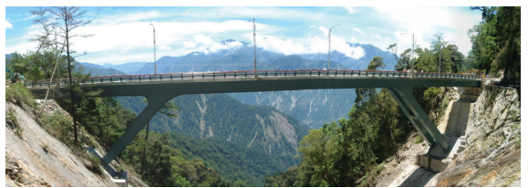
▲大雪山林道「32k+700~32k+800」災害復建工程全貌（攝影／東勢林區管理處 鄭筱蓁）。
