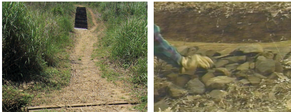
▲ 左：排水不良步道段可考慮建排水坡降；右：標準排水坡降 (USDA Forest Service 提供)。
