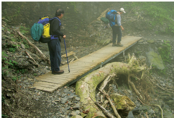
▲木橋上坡需置水的消能設施。
