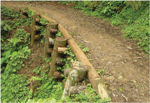
▲ 木格框架擋土牆。
