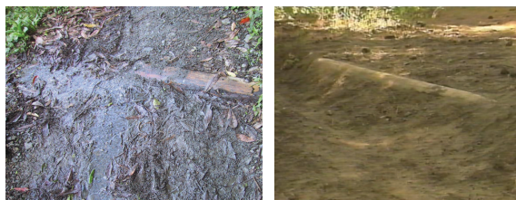
▲左：導流棒與步道角度小於 30^{\circ} ，可能會因水速降低太多而使泥沙等雜物淤積阻塞導流棒；右：標準導流棒 (USDA Forest Service提供)。
