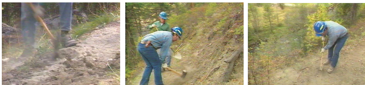
▲整修中 (USDA Forest Service 提供) 一左：清除突出路肩，中：清除滑落砂石，右：鏟平步道面使其具有外斜坡。
