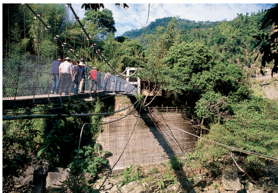
▲正在籌建之兩座吊橋，量體巨大。
