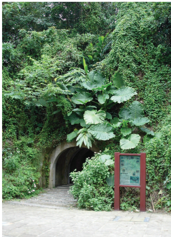
▲富陽自然生態公園內的一處涵洞。
