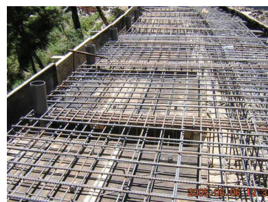
▲照片4 配筋、配模。
