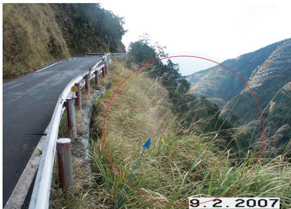
▲照片13 下邊坡（拓寬完竣後上下邊坡保持原有面貌雜草及原有生態）。
