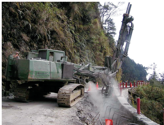
▲照片5 挖基礎、鑽孔。
