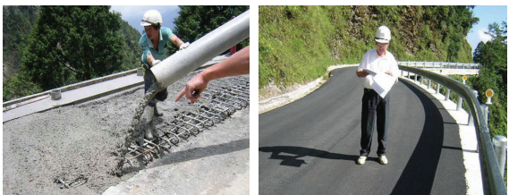
▲照片9、10 灌漿、鋪柏油（右），施工後正面（左）。
