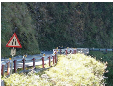
▲照片3 施工前側面(路寬2.8~3.5 m 邊坡陡峻，護欄易遭受撞擊)。
