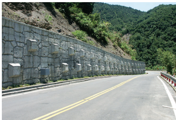
▲宜專一線6.5 km地錨工法。
