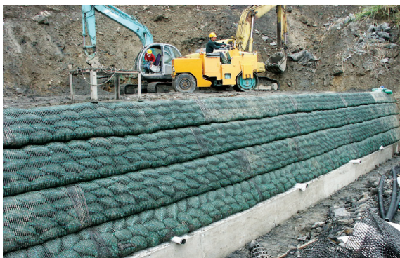
▲基礎及第一層加勁擋土牆施設。
