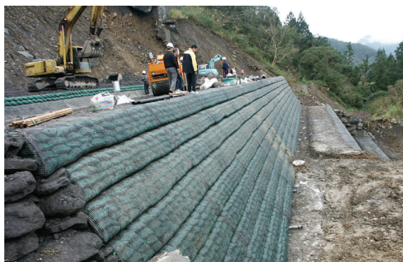
▲2~3層加勁擋土牆施設。
