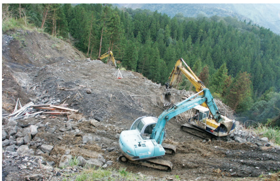
▲測量及開挖基礎。
