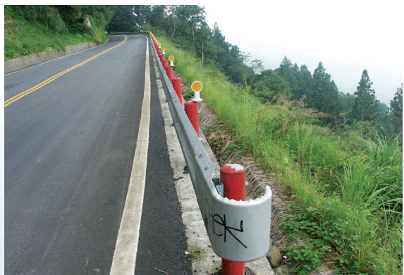
▲宜專一線11.5 km加勁擋土牆工法。
