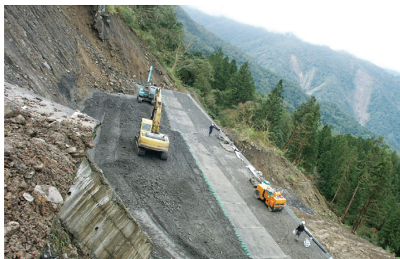
▲3~4層加勁擋土牆施設。
