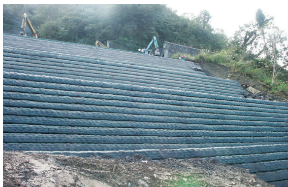
▲5~6層加勁擋土牆施設近完工。
