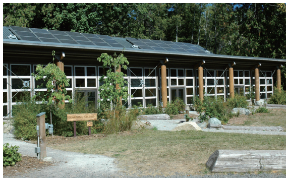
▲照片17 教學教室屋頂所設置的大型太陽能光電板，可提供每年50%的照明及電力使用需求。
