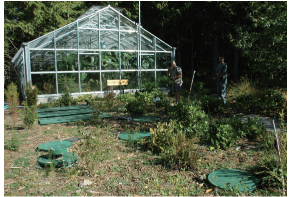
▲照片38 埋設於植物淨化工廠外、做為進行生菌分解的過濾槽（圖8之2）。
