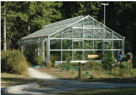
▲照片36 植物淨化工廠是自然中心進行生活廢污水處理的重要設施。
