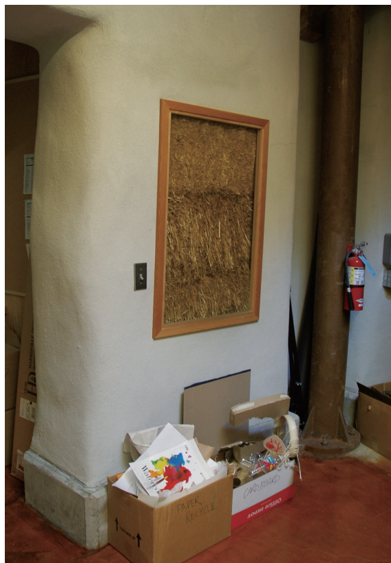
▲照片22 運用麥稈捆紮建構而成的教室牆壁。
