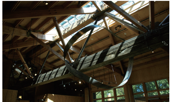
▲照片4 運用鋸木刀片圍繞一92英尺長、120年前伐採之巨木所設置的屋頂桁架設計，是闡述普吉特峽灣地區早年伐木歷史的最佳說明。
