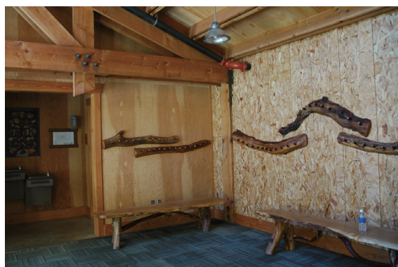
▲照片12 餐廳玄關及廁所牆面採用回收木料、地板則運用回收地毯製作而成。
