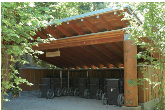
▲照片33、34 置放腳踏車及搬運車的木造亭棚。
