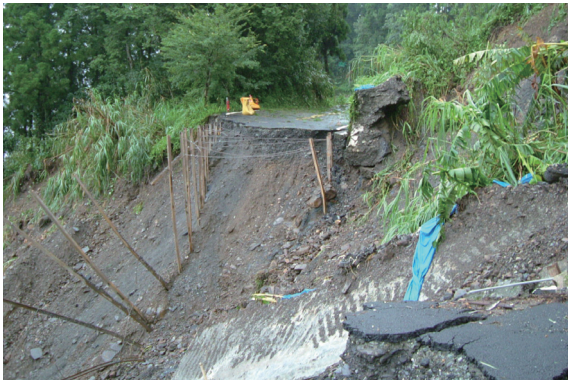
▲照片3 94年海棠颱風6.5 k路基流失及地層滑動。
