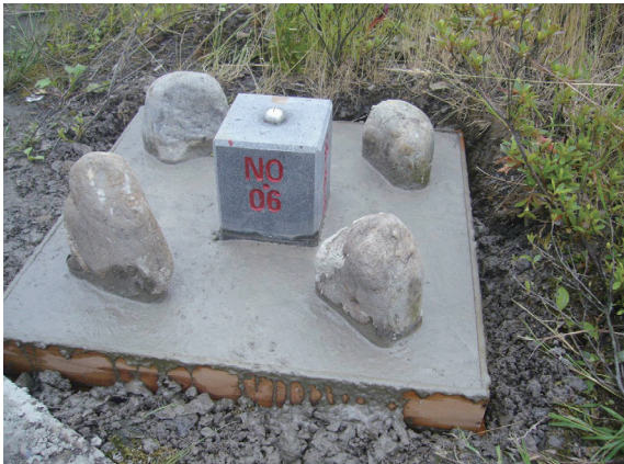
▲照片10 GPS測量及樁位埋設。
