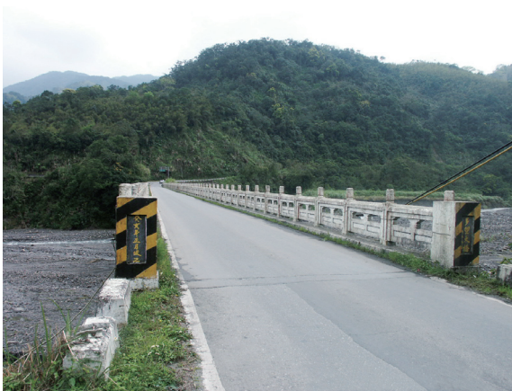
▲照片1 宜專一線公路多望橋現況（拍攝時間97年2月16日。
