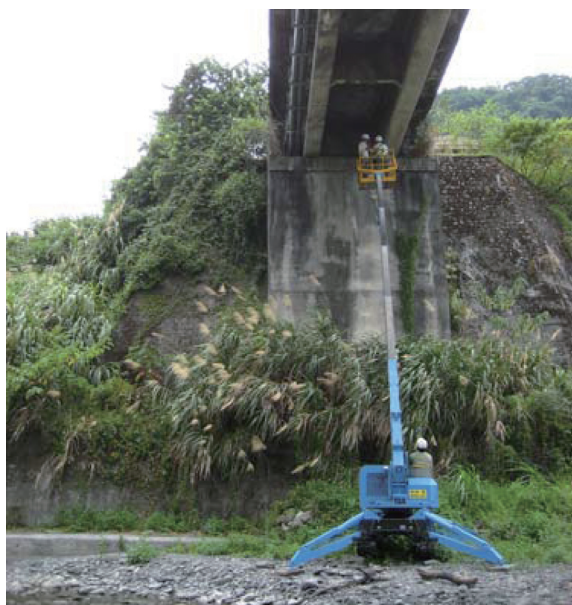
▲照片3 多望橋橋面、帽梁檢視。
