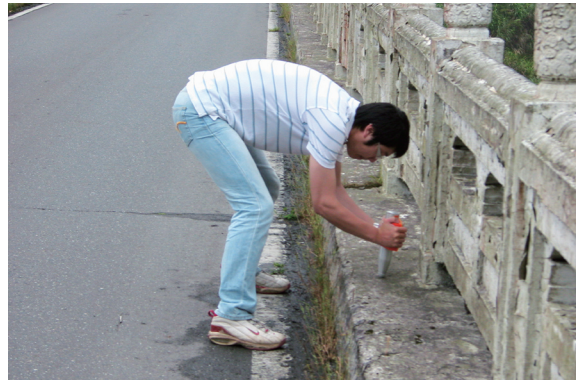
▲照片2 多望大橋兩側欄杆基座之混凝土，以混凝土反彈衝錘進行非破壞性檢驗。
