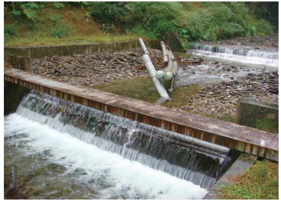
▲福山植物園的二號量水堰，在颱風過後，常常被沖刷出來的泥沙堆滿。值得注意的是該集水區的森林覆蓋率接近100%。如何經營管理呢？
