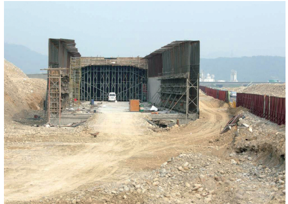
▲照片1 施工中的火炎山隧道口（拍攝日期：94年4月5日）。
