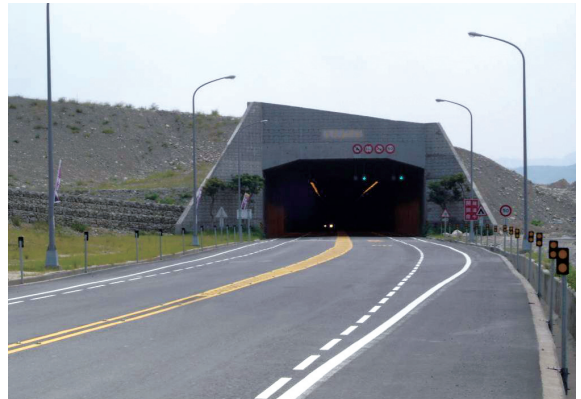
▲照片2 完工的火炎山隧道（拍攝日期：95年2月28日）。
