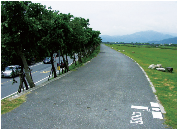
▲堤岸闢為自行車道。
