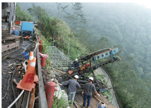
▲照片5 宜專一線6k+300~500m地錨施設。
