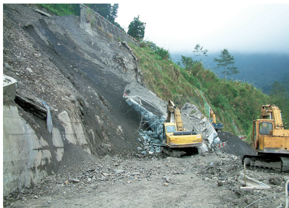
▲照片3 宜專一線6k+200m鋼筋混凝土打除及坍方清除。
