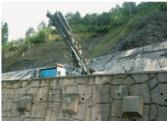
▲照片7 宜專一線6k+300~700m地錨施設。
