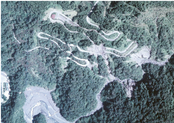
圖5 2005年10月納莉颱風後之航照圖：顯示道路受崩塌而中斷，崩塌區域內正進行道路緊急搶通工程，道路排水直接排往下邊坡所造成之沖蝕。
