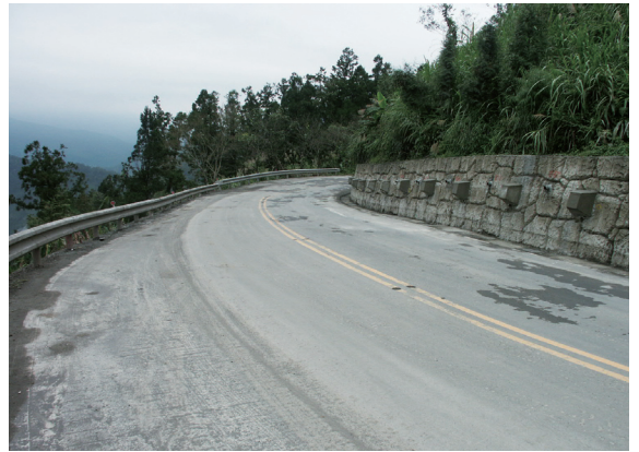
▲照片11 擋土牆預力地錨、排水管補設。
