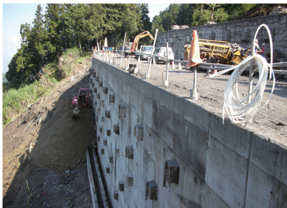
▲照片6 宜專一線6k+500~700m地錨施設。
